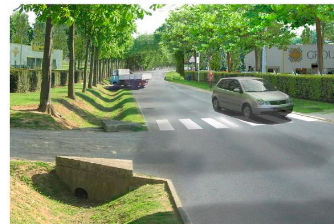
Figure 23 – Illustration de l'implantation de noues en zone urbaines
